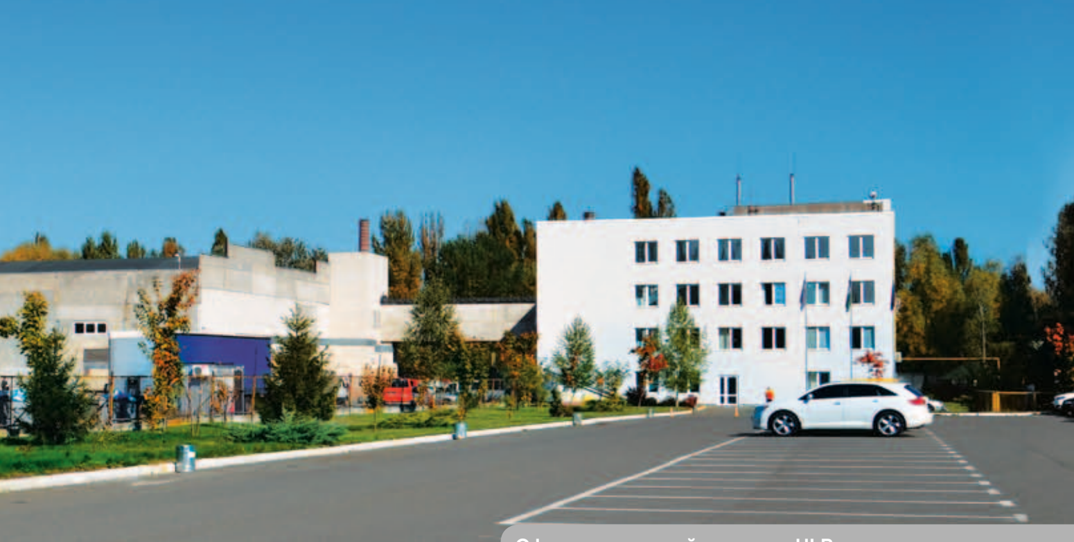
Офисно-складской комплекс HLR
